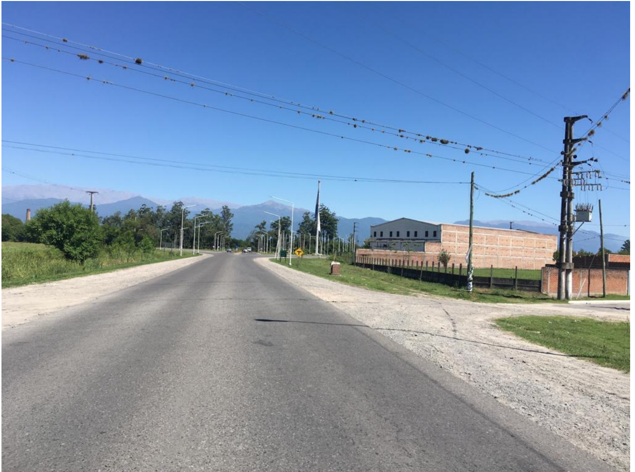
Fotografía 02: obsérvese demarcación difusa de las líneas en la calzada.
