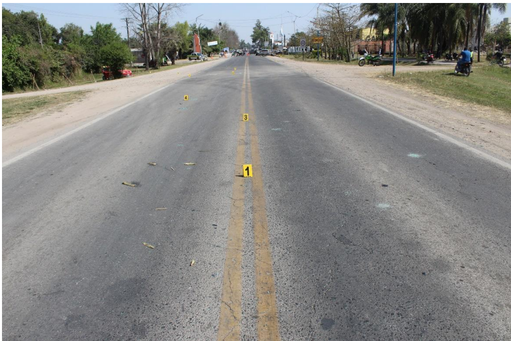
FOTOGRAFIA N°3: Toma en aproximación de la calzada donde se observa un marcador de indicio N° 1, señalando restos dispersos de vidrios sobre la calzada.
