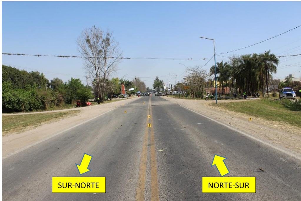
FOTOGRAFIA N° 2: Vista panorámica con mayor acercamiento de la escena. Se observa la calzada de asfalto, las banquetas laterales de tierra compacta y la señalización horizontal (doble línea continua central y demarcación de los carriles), bajo iluminación natural diurna. Se señala con flecha el sentido de circulación de los carriles para su mejor localización.
