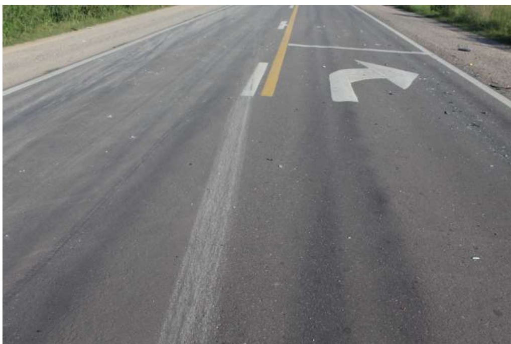
Fotografía n°9: Continuidad de imagen anterior, obsérvese acrílicos dispersos como así también marcas de fricción.-
