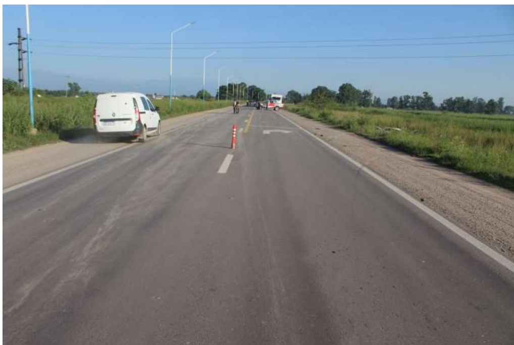
Fotografía n°6: Continuidad de imagen anterior, obsérvese marcas de fricción con proyección hacia banquina Este. -
