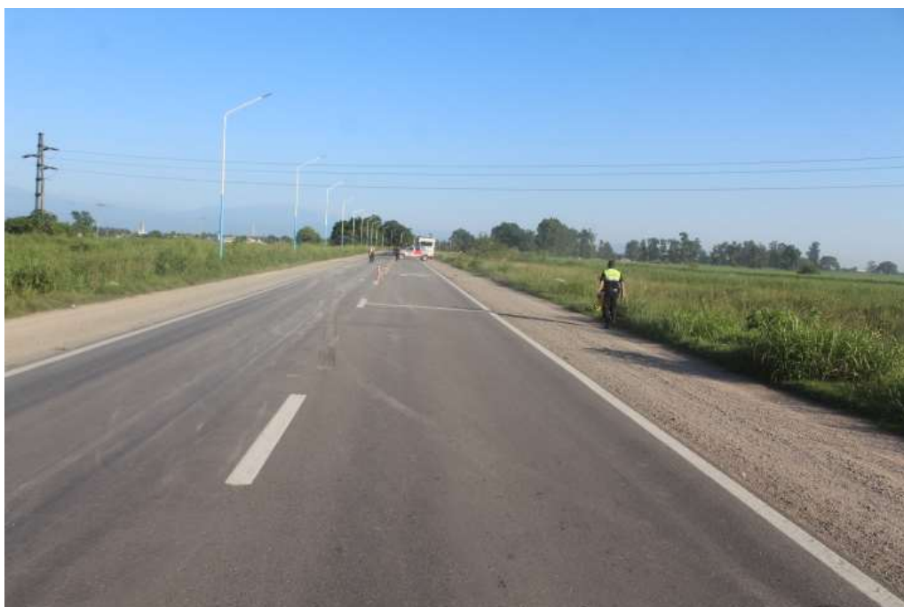
Fotografía n°2: Continuidad de imagen anterior, obsérvese marcas de fricción sobre calzada.-
