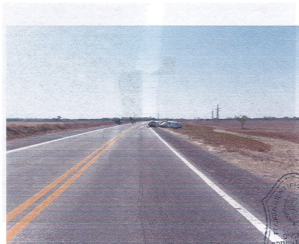
FOTOGRAFIA N° 01: toma realizada en forma panorámica desde el cardinal Sur a Norte, sobre el carril Este de la Ruta Nacional n° 38 (traza nueva).
