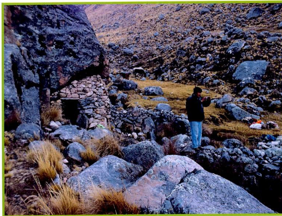
Figura 12. Sectores altos del territorio. Empleo de aleros, cuevas o grandes bloques rocosos, a los que se anexa un muro de pirca seca como cerramiento.
