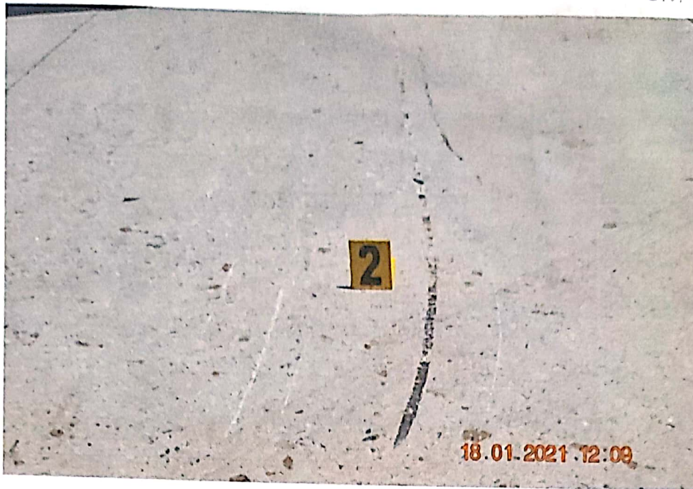
Fotografía n° 8: Realizada para mostrar inicio del al fricción metálica discontinua y mancha oscura.-
