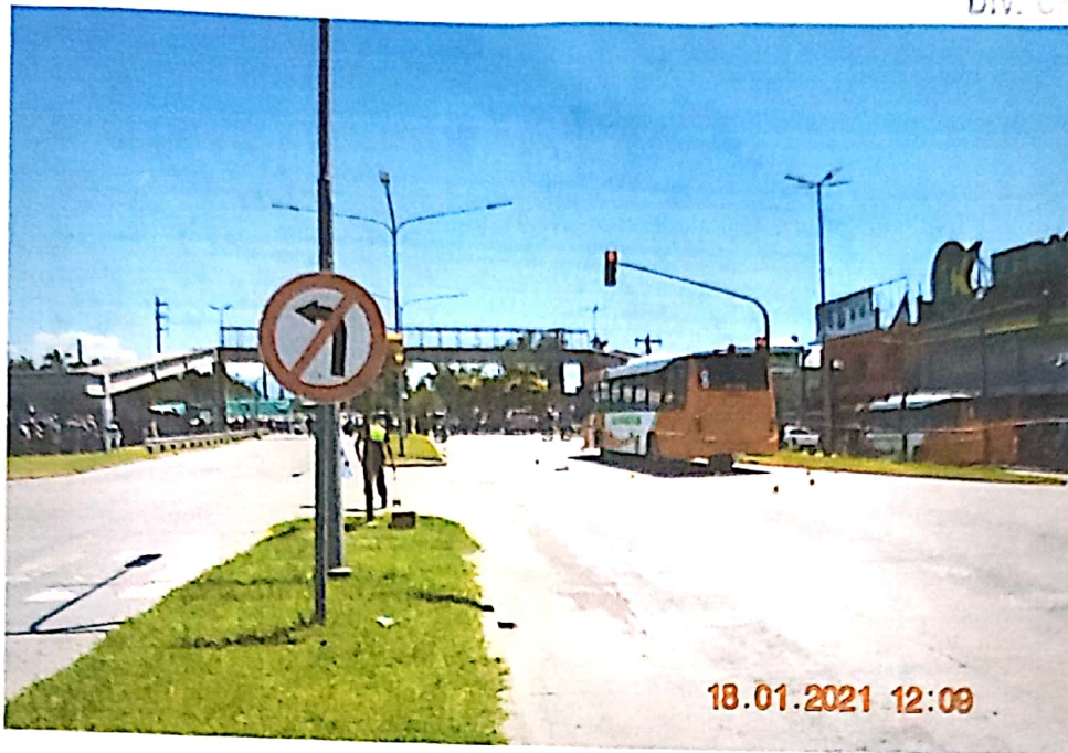
Fotografía n° 4: Toma a la señal vertical, en la platabanda.-
