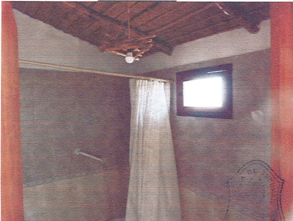
FOTOGRAFIA N° 25: Realizada en el baño de la cabaña.-
