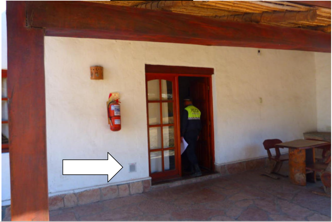
FOTOGRAFIA N° 2: Toma a la puerta de ingreso de la cabaña nro.05 donde se observa una rejilla de ventilación y se la indica con flecha inserta.-
