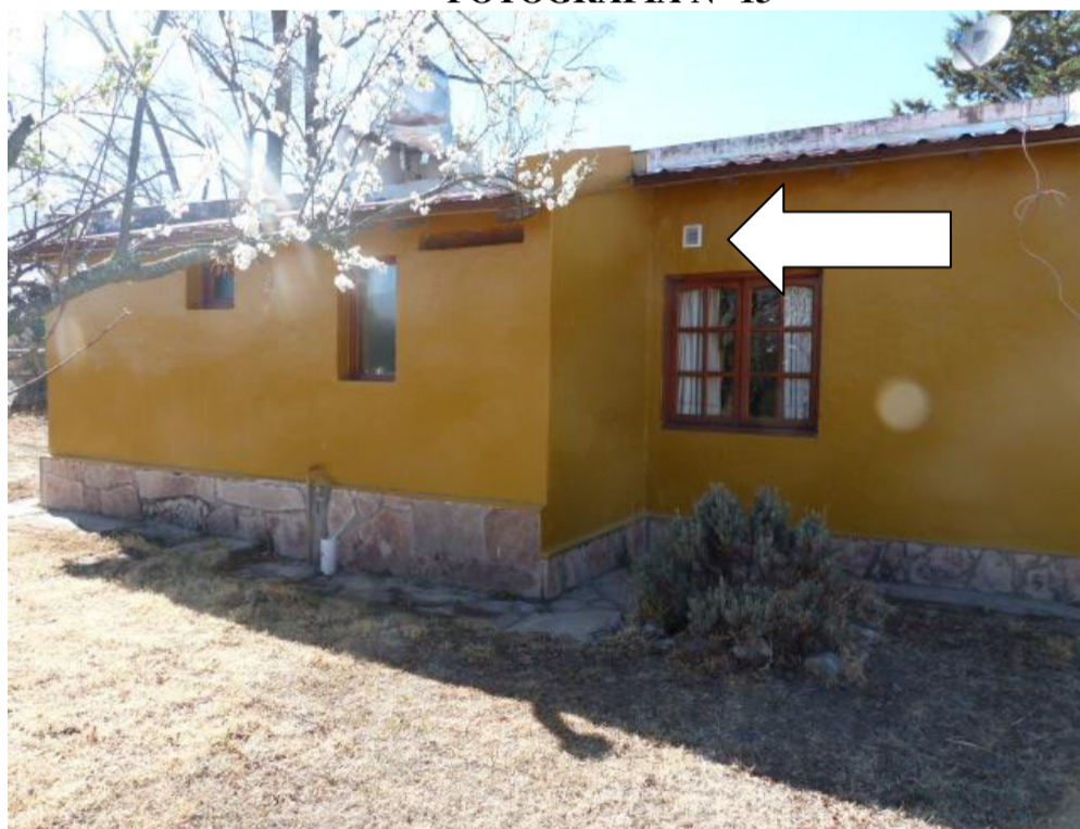
FOTOGRAFIA N° 13: Toma realizada desde la parte externa de la cabaña nro. 05 donde se indica con flecha inserta la rejilla de ventilación en la pared.-
