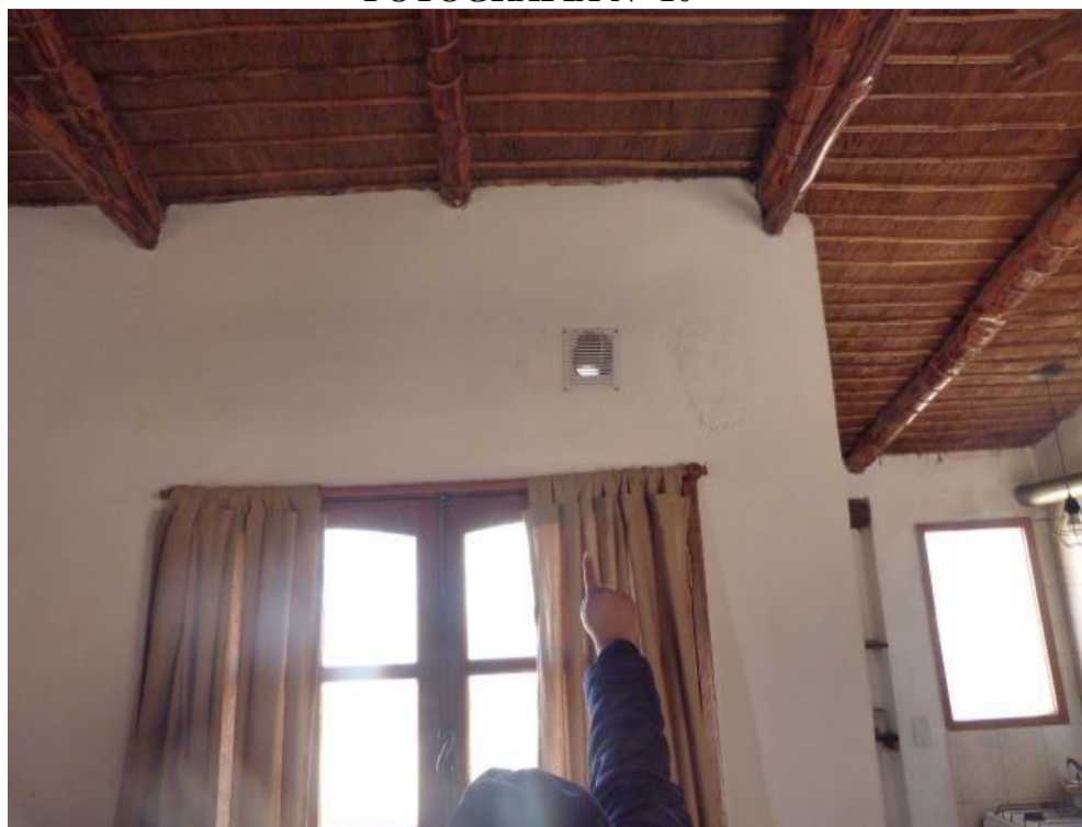
FOTOGRAFIA N° 10: Personal policial indica la rejilla de ventilación colocada en lo alto de la pared.-
