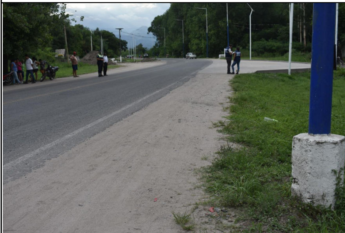
Fotografía Nro. 3: Vista panorámica tomada desde la banquina Noreste, con ángulo de toma hacia el cardinal Noroeste. Se observa a personal del ECIF realizando el relevamiento.
