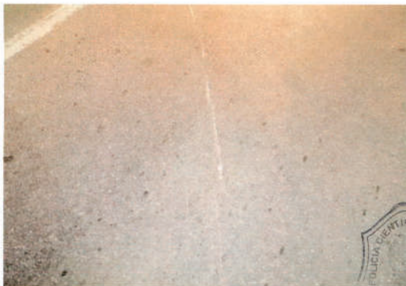
FOTOGRAFIA N° 12: Tomada en detalle al Raspado Metálico sobre la cinta asfáltica. -
