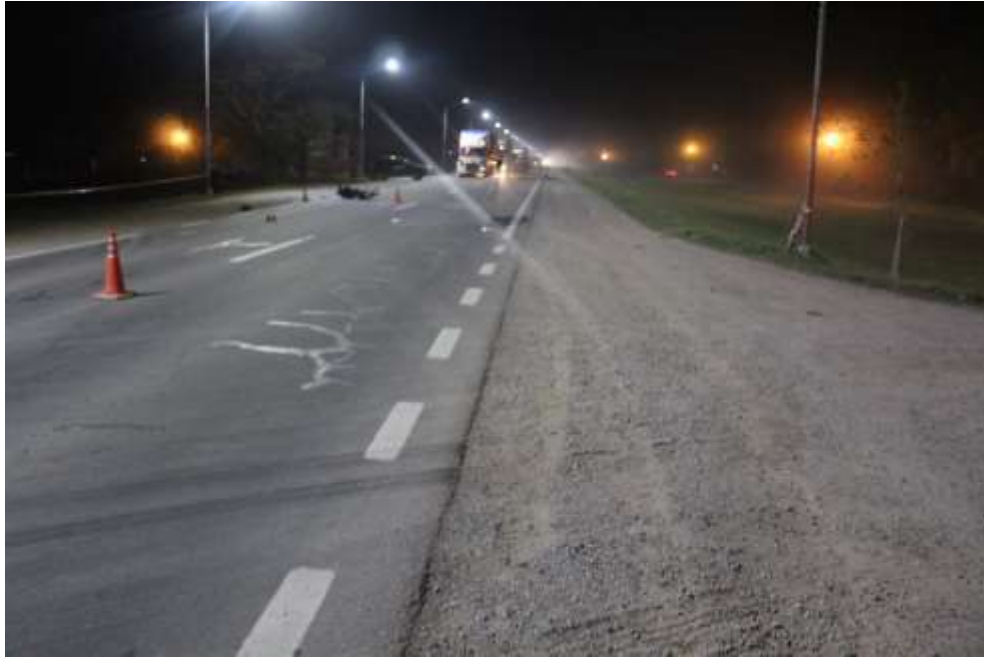
Fotografía n°6: Panorámica de Sur a Norte, por banquina Este, donde se observa huella de rodamiento. -
