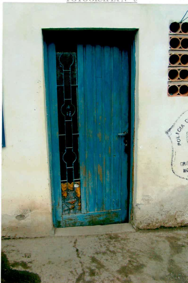
FOTOGRAFIA N ° 5: Se muestra con mas detalle puerta de acceso al sector de la cerradura.-
