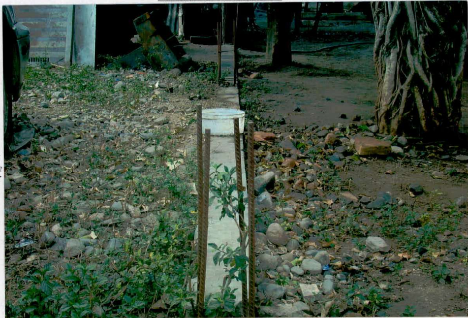
FOTOGRAFIA N ° 14: En forma parcial se observa base de cimientos y base de columnas con hierros, que delitan el terreno.-
