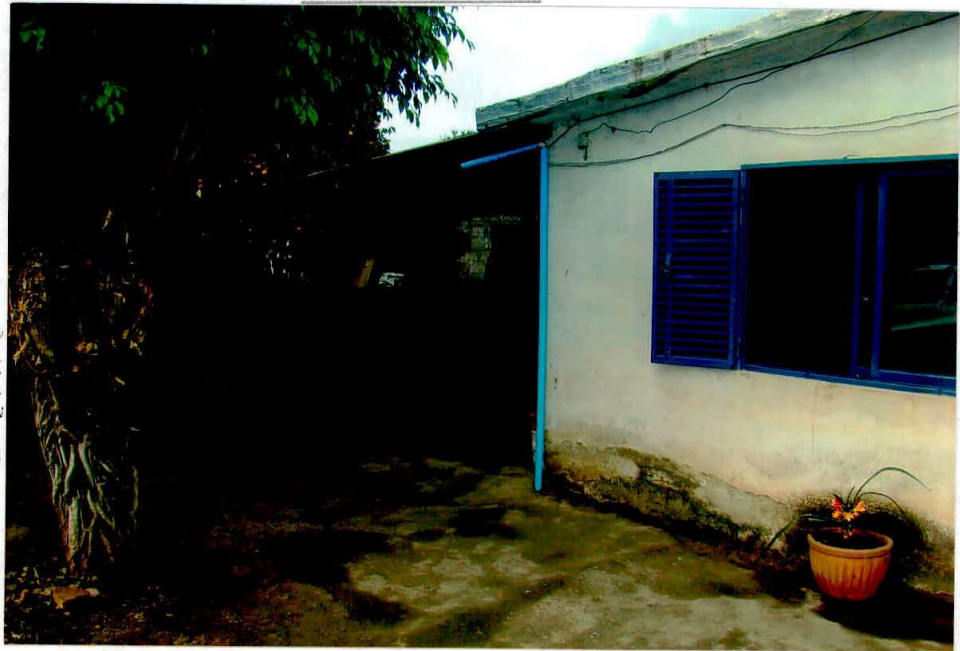
FOTOGRAFIA N ° 8: En forma parcial se observa costado de la casa que se guía hacia el fondo.-
