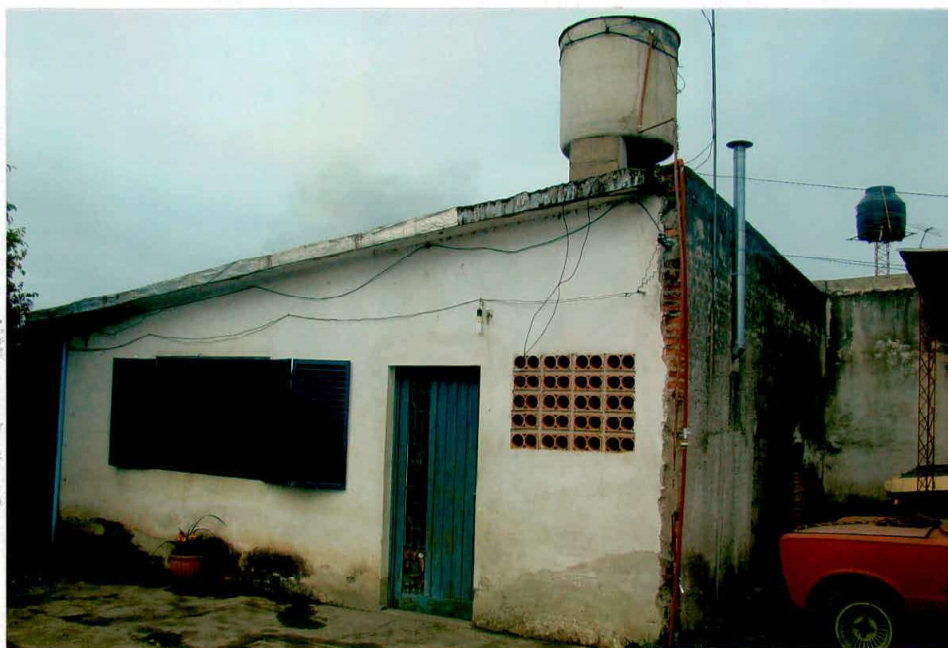
FOTOGRAFIA N ° 4: Tomada de cardinal Norte a Sur sobre el terreno en cuestión, se observa frente a la propiedad, se observa puerta de acceso.-
