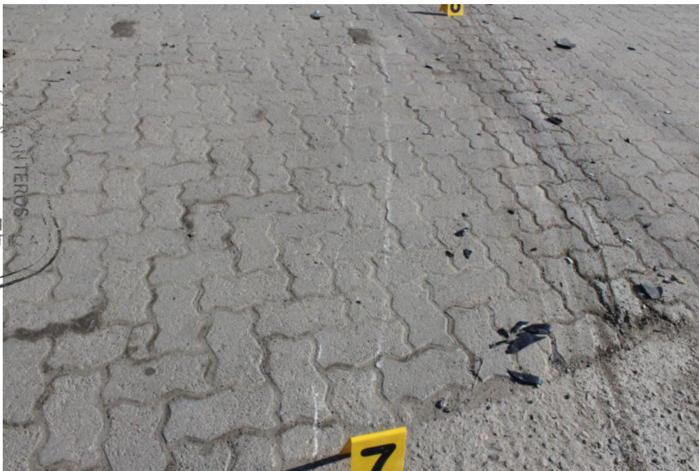
Fotografía n° 23: Toma en detalle de huellas de efracciones, neumáticos y restos de material plástico.
