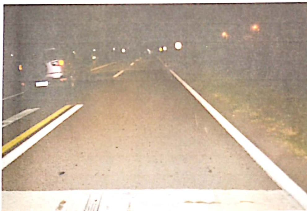
Fotografía n°5: Se observa marca de fricción.-
