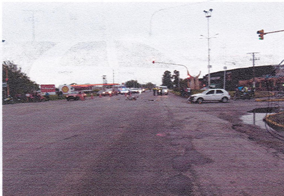
FOTOGRAFIA N° 01: Panorámica realizada, sobre Ruta Nacional 38 y Av. España, Monteros
