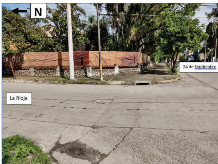
Fig. N° 3: Cerramiento en una propiedad situada en la esquina Noreste de la intersección de calles La Rioja y 24 de Septiembre.
