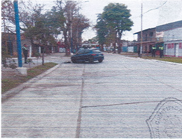
FOTOGRAFIA N°12: Toma panorámica realizada sobre Av. Alem desde el cardinal Oeste a Este.-
