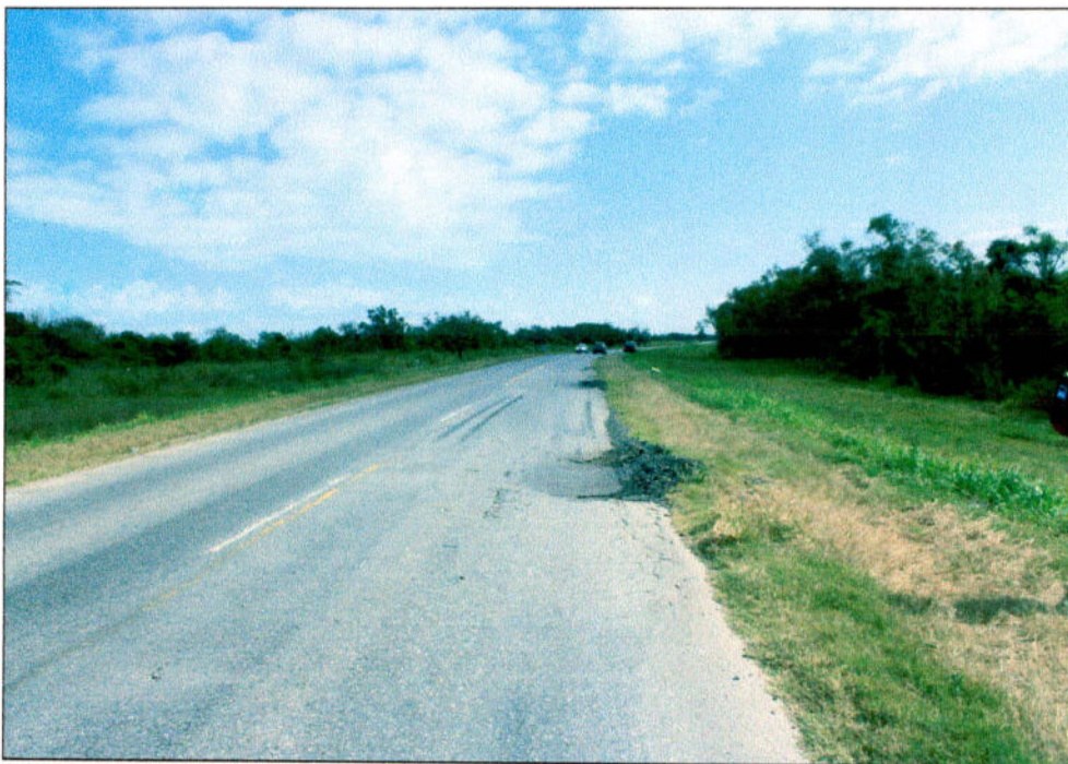
Fotografía n° 1: panorámica de sur a norte por ruta nacional n° 157 altura pampa mayo se observan los baches en el carril este
